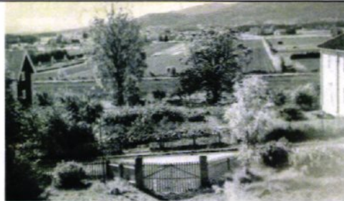
Opprinnelig var det innkjøring til eiendommen fra langsiden
