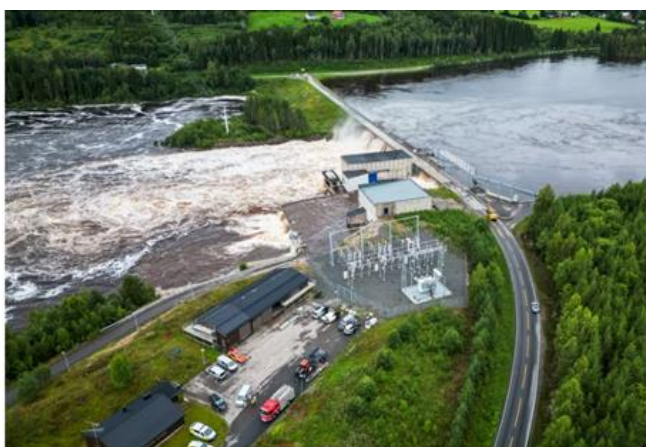
DRAMA: Vann har trengt inn i kraftverket på Braskereidfoss i Våler kommune i Innlandet. Foto: Tor Bergebakken / Østlendingen
