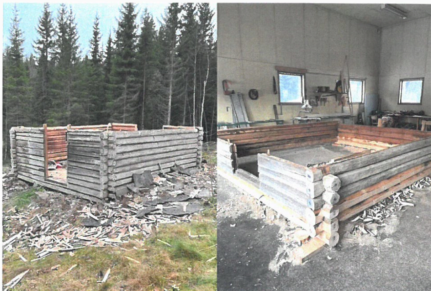
Hanstukoia under nedplukking og restaurering
